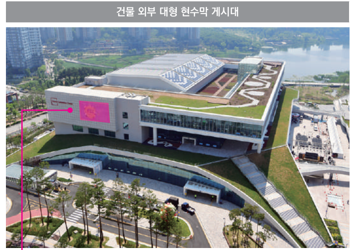
건물 외부 대형 현수막 게시대 • 규격 사이즈 : 14.2m x 8m • 시공방법 : 사방줄미싱
